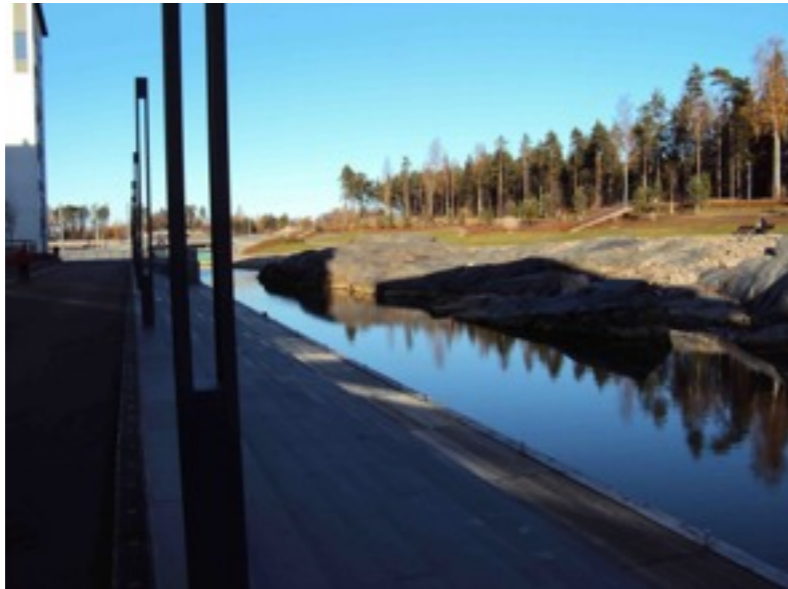
Helsinki, Aurinkolahden kanava on osa hulevesien hallintajärjestelmää
